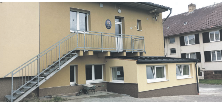
Přístavba šatny MŠ Ráček
